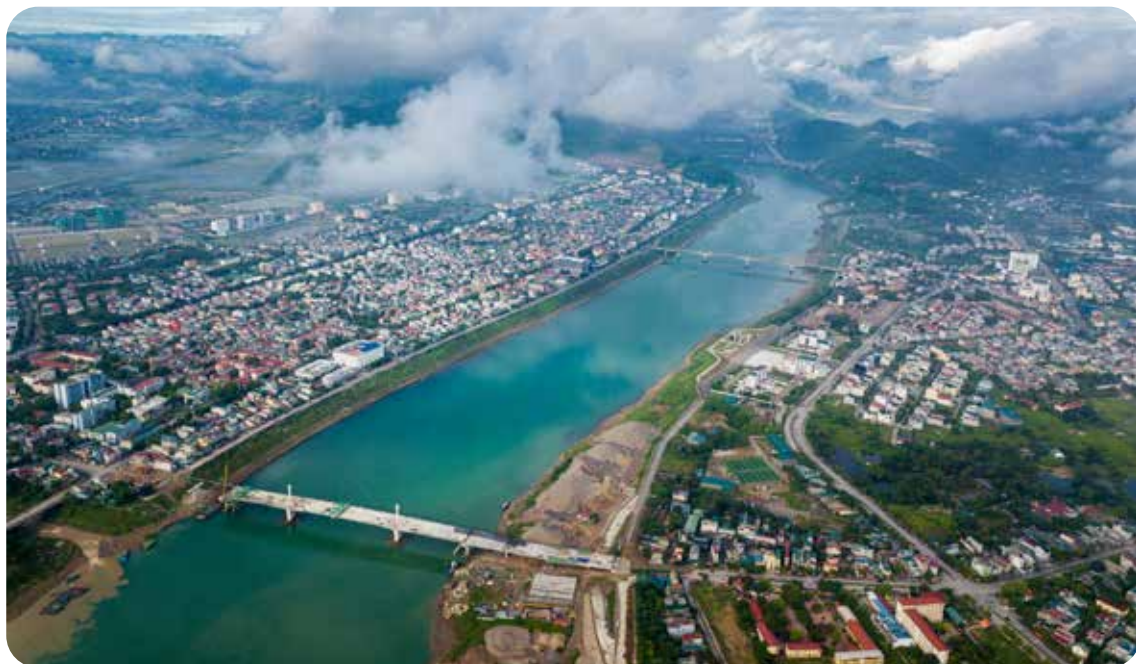
Hình 7.2. Thành phố Hoà Bình
